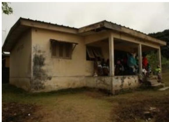
**Fig 5 :** Etat de délabrement de la charpente, de l'exiguïté et de la vétusté du mur
